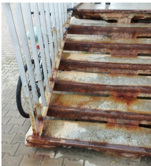
Zdjęcie nr 2. Schody do Ośrodka Rehabilitacji Leczniczej o nieprawidłowych parametrach (stopnie i poręcz)
