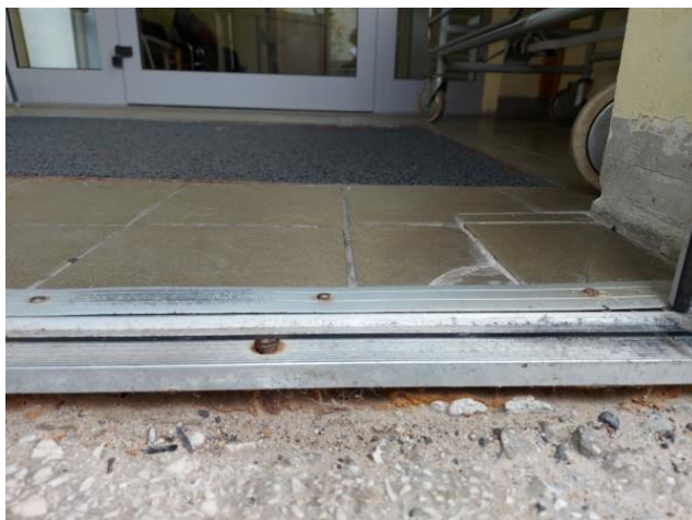
Zdjęcie nr 3. Próg w drzwiach wejściowych o wysokości powyżej 2 cm
